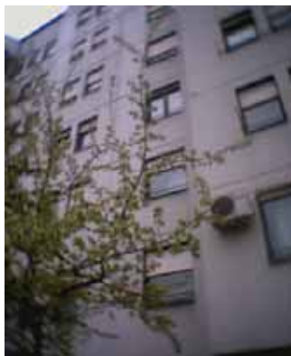
Slika 1. Demonstracioni objekat u bloku 34, bul AVNOJa 209-217
