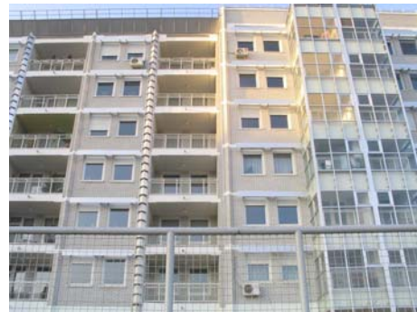
Slika 2. Demonstracioni objekat u bloku
